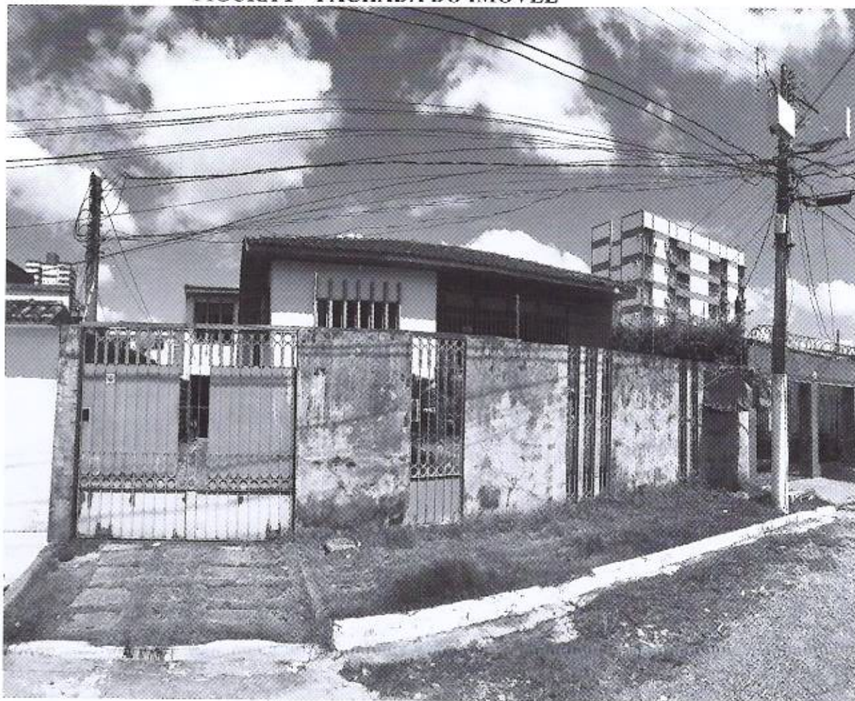
FIGURA 1 – FACHADA DO IMÓVEL
