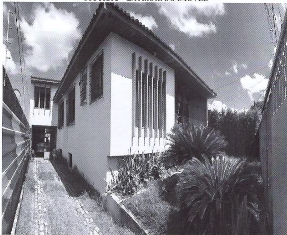
FIGURA 2 – LATERAL DO IMÓVEL
