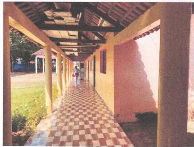
FOTO 21: ÁREA DE CIRCULAÇÃO
