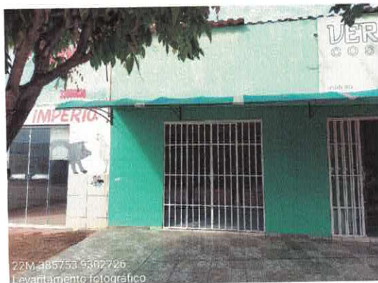
Imagem 1 - Fachada do imóvel
