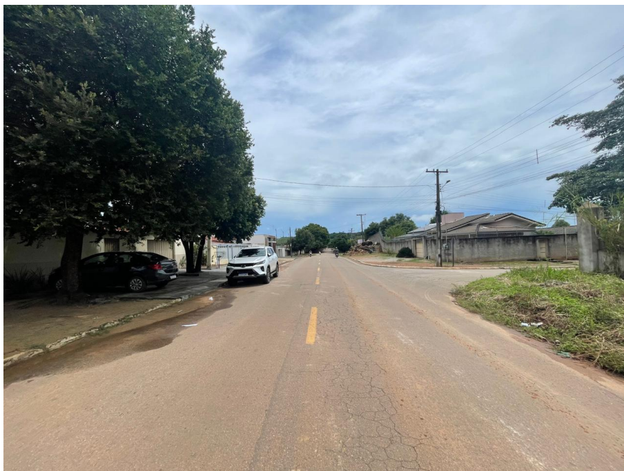
IMAGEM 1: VISTA LATERAL DIREITA À EDIFICAÇÃO
