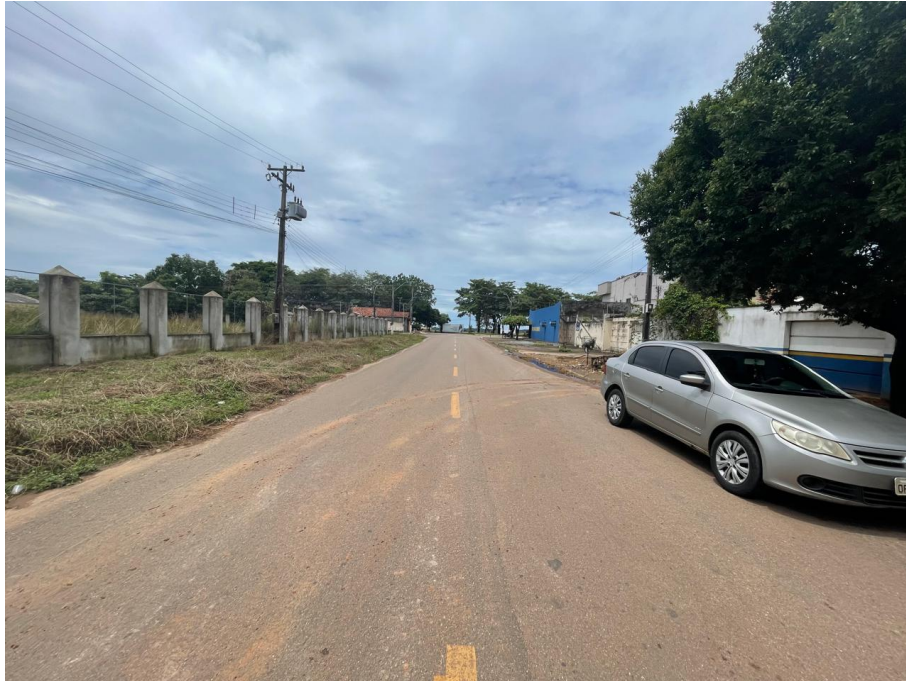
IMAGEM 2: VISTA LATERAL ESQUERDA À EDIFICAÇÃO
