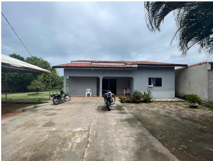
IMAGEM 4: VISTA ANTERIOR DA EDIFICAÇÃO
