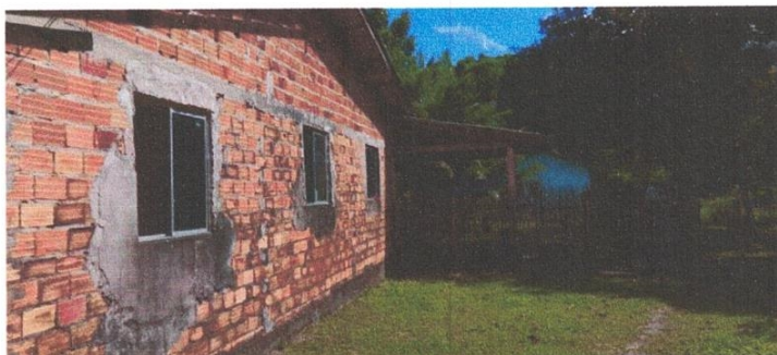
Reboco da Parede Externa
