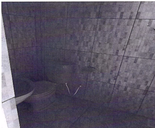
FOTO 04: BANHEIRO DAS SALAS DE AULA
