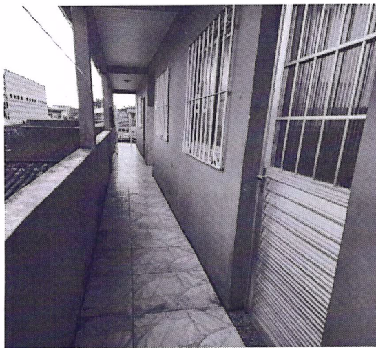
FOTO 04: CORREDOR/ 1º PAVIMENTO
