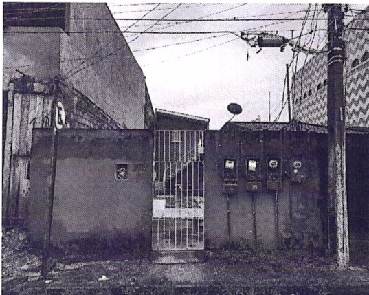
FOTO 01: FACHADA DO PRÉDIO
