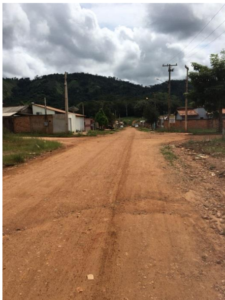
Ponto 2.1: Rua Lateral
