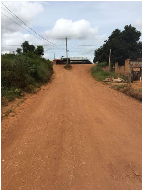
Ponto 1.1: Início do trecho, da rua no sentido PA279.
