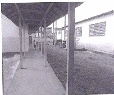
FOTO 05 : ÁREA DE CIRCULAÇÃO
