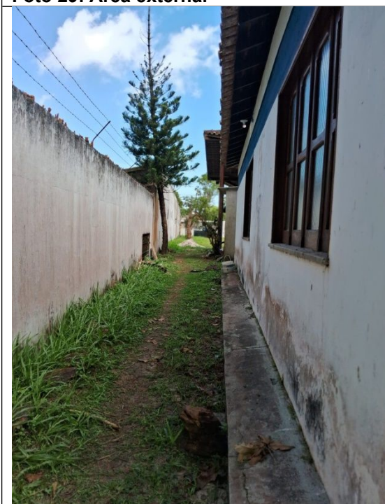
Foto 31: Corredor de circulação da área externa.
