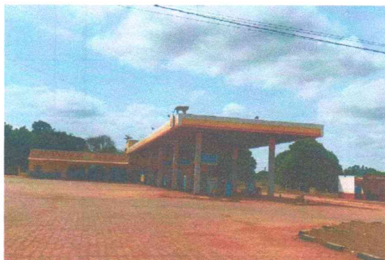
Figura 1 Faixada Posto Arrudão
