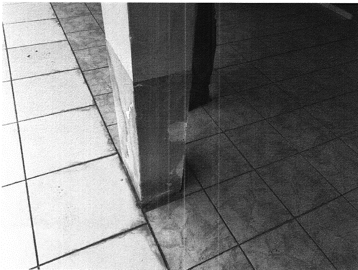
Foto 06 Pé de pilares recuperados
