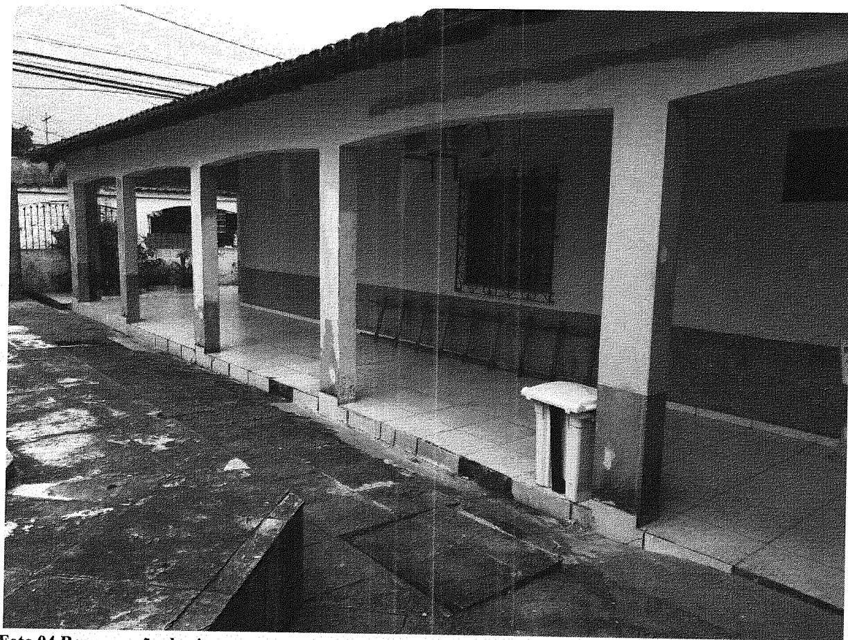
Foto 04 Recuperação de vigas
