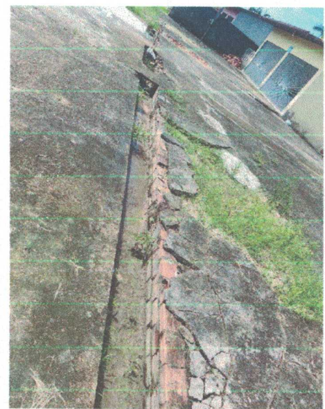
Piso e canaleta de acesso ao prédio.
