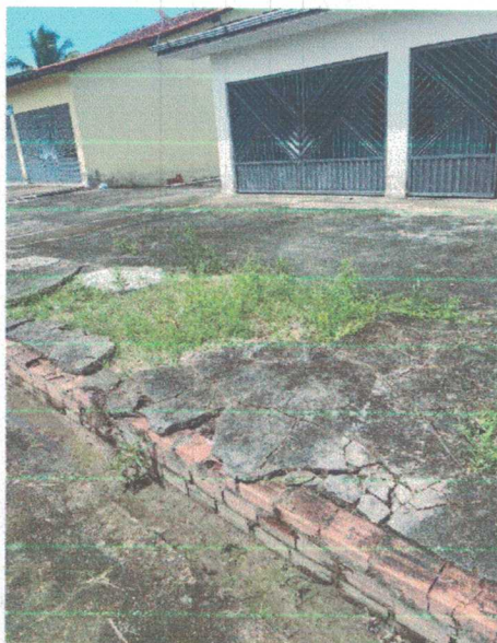
Piso e canaleta de acesso ao prédio.
