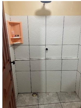
Imagem 10: Banheiro 02, área de banho.
