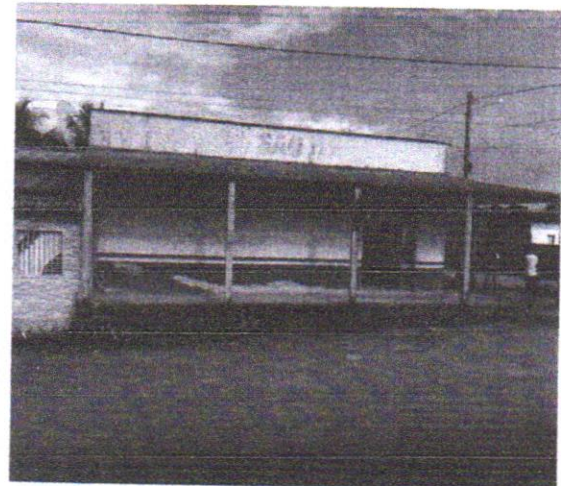
Foto 04 – Fachada lateral esquerda
