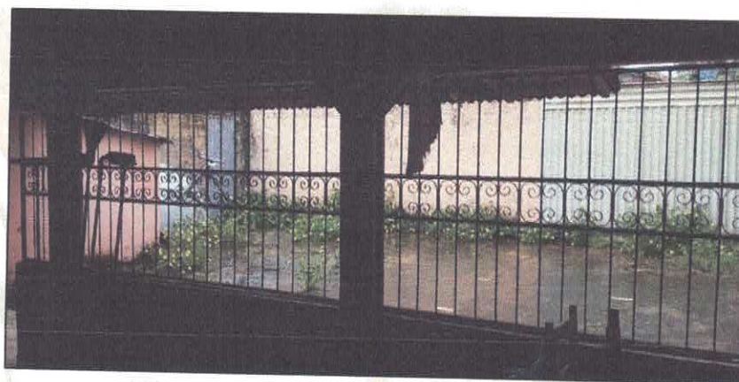
Figura 8: Varanda da entrada pela Rua Recife.
