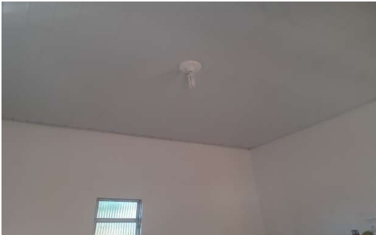
FOTO 05: FORRO EM LÂMINA PVC.
