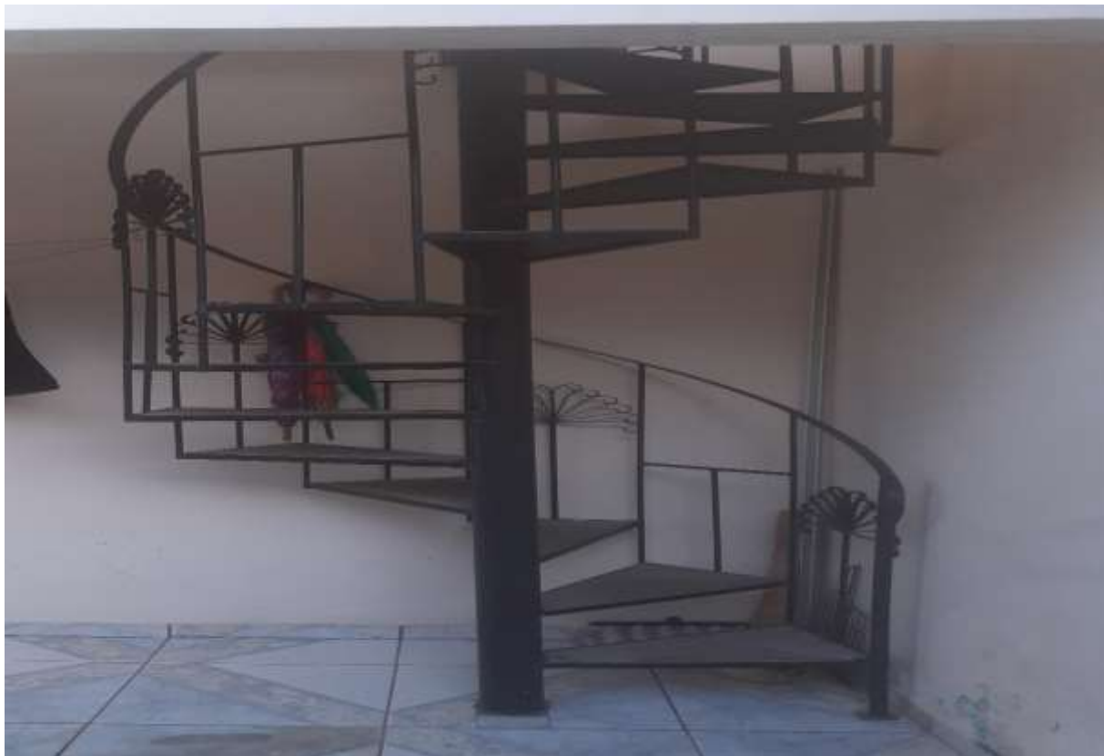
FOTO 07: ESCADA METÁLICA – ACESSO AO PAVIMENTO SUPERIOR.
