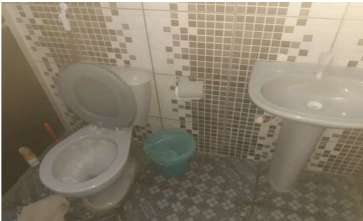
FOTO 04: BANHEIRO - REVESTIMENTO CERÂMICO DE PAREDE E LOUÇAS
