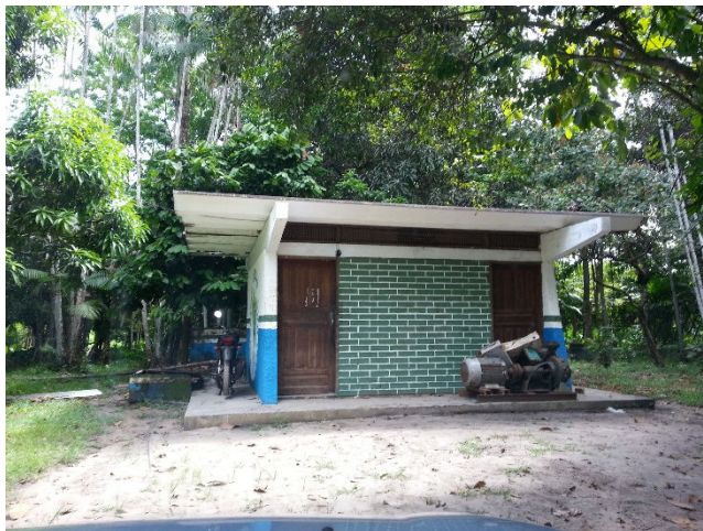
Elevatória do Parque Ambiental, succiona de 07 poços rasos
