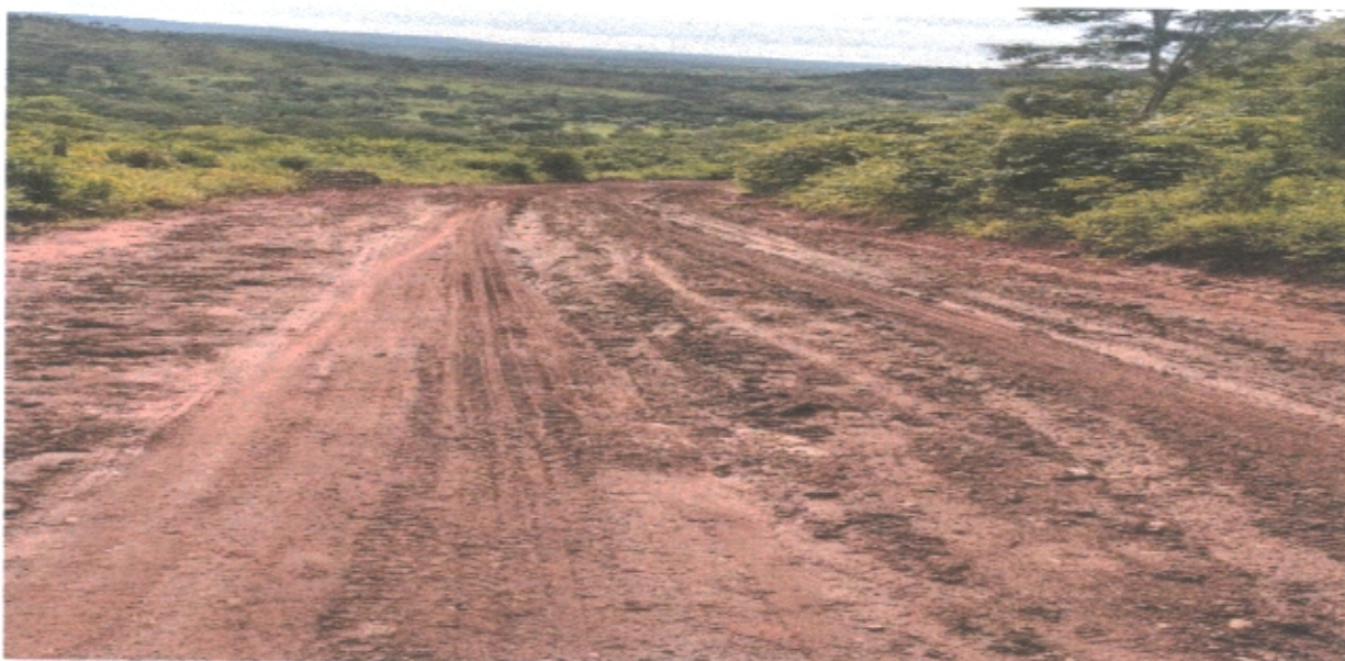
01 – ESTRADA VICINAL CAMPINHO / Km. 03 / FOTO em 02/04/2018
