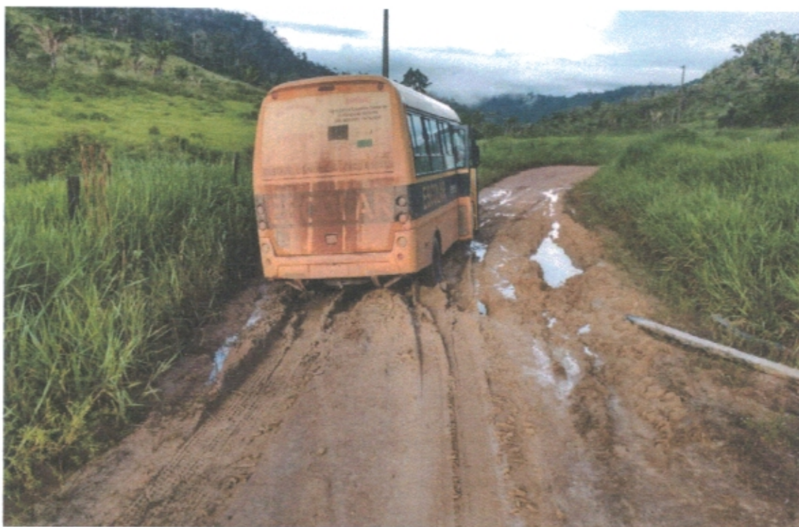
11 – ESTRADA VICINAL CAMPINHO / Km. 92 / FOTO em 02/04/2018
