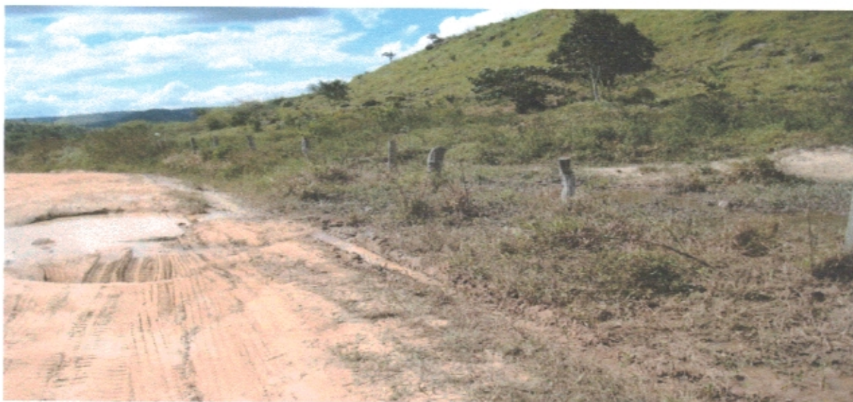
08 – ESTRADA VICINAL CAMPINHO / Km. 61 / FOTO em 02/04/2018
