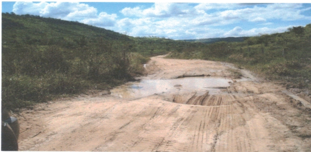
09 – ESTRADA VICINAL CAMPINHO / Km. 78 / FOTO em 02/04/2018
