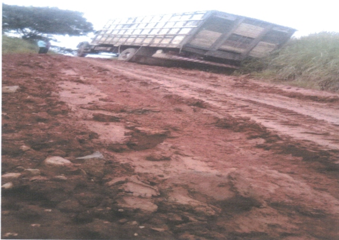
10 – ESTRADA VICINAL CAMPINHO / Km. 84 / FOTO em 02/04/2018
