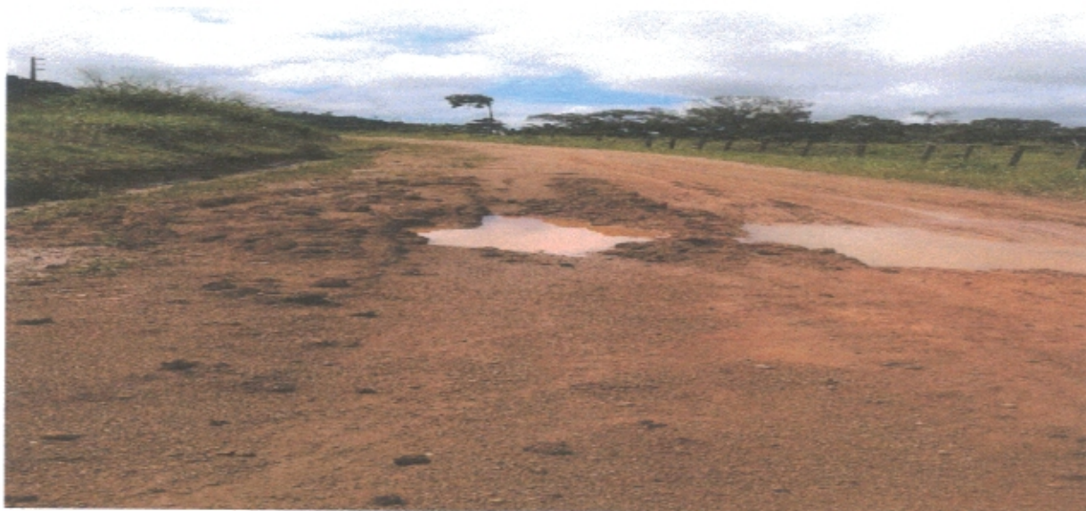
02 – ESTRADA VICINAL CAMPINHO / Km. 09 / FOTO em 02/04/2018
