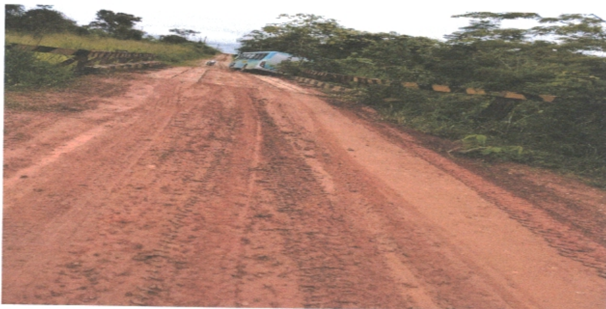
04 – ESTRADA VICINAL CAMPINHO / Km. 24 / FOTO em 02/04/2018
