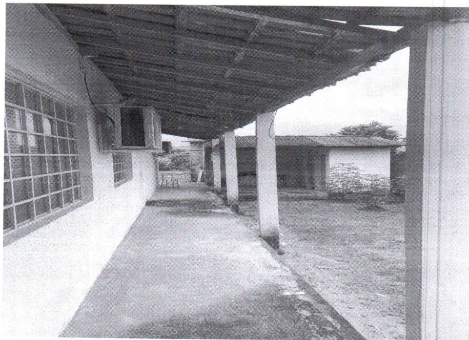
Imagem 02 – Corredor acesso banheiro.
