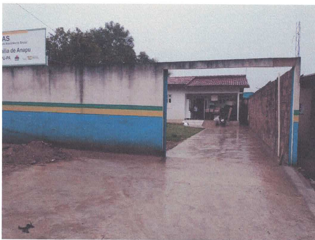
Imagem 01 – Vista Frontal Muro
