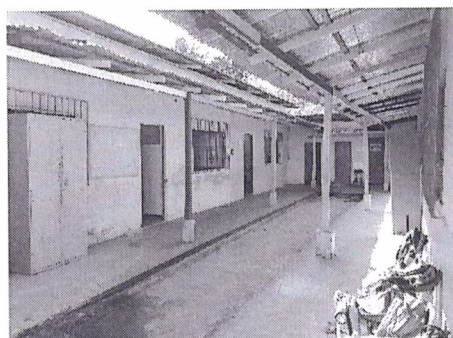
FOTO 06- PASSARELAS DE ACESSO
