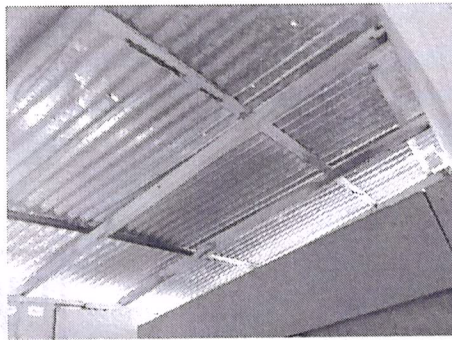
FOTO 10- TELHADO DO BANHEIRO
