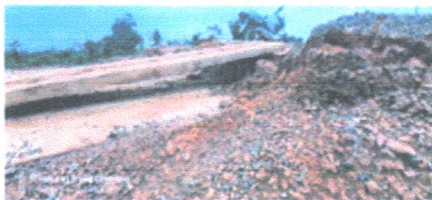
FOTO 02: Ponte na estrada do Cristal
