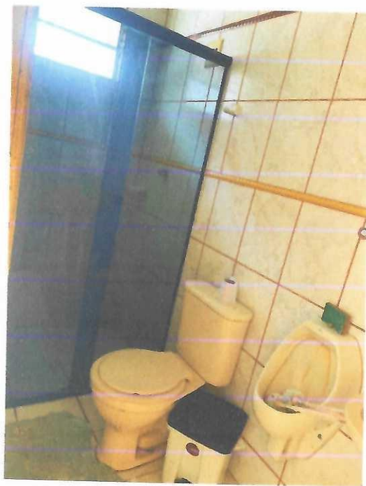
Vista Interna Banheiro
