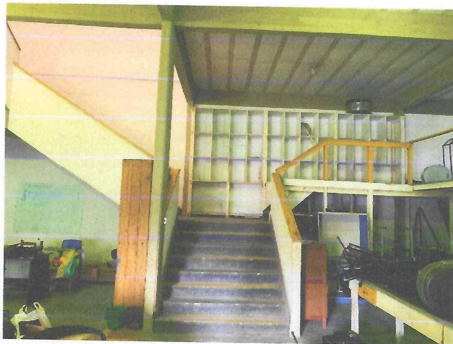
Vista interna Escada de Acesso Sala 02
