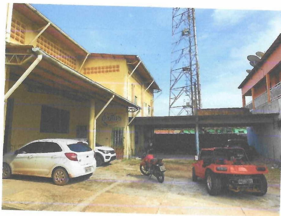
Vista Lateral da Edificação
