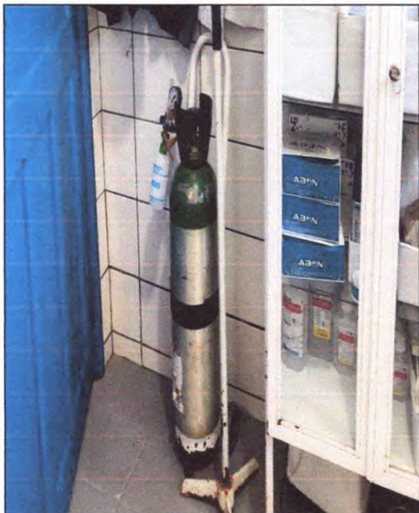
Figura 1. Cilindro de gás medicinal enferrujado – UBS Novo Brasil.
