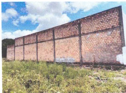
Imagem 02: Lateral do imóvel
