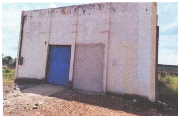
Imagem 01: Fachada do imóvel
