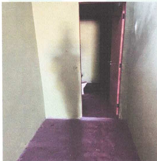
Imagem 05: entrada do Banheiro do imóvel
