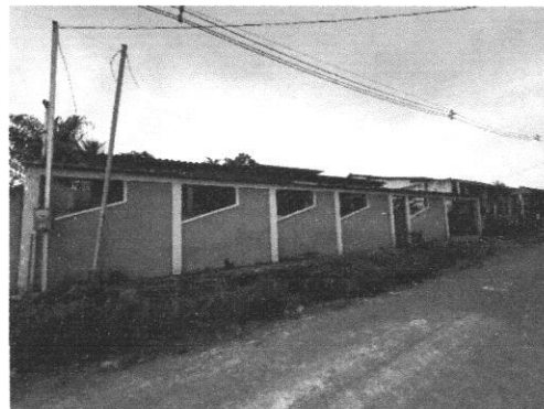
Figura 17: Muro da Fachada
