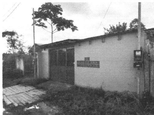
Figura 18: Muro da Fachada
