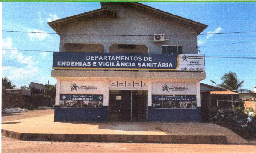
Fotografia 1: Fachada e entrada da edificação.
