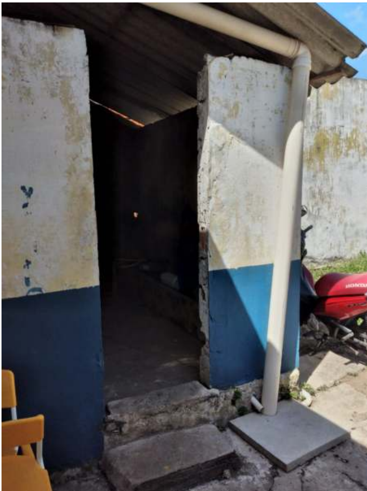
FOTO 07 – REFORMA GERAL NO DEPOSITO COM INSTALAÇÃO DE PORTA DE MADEIRA
