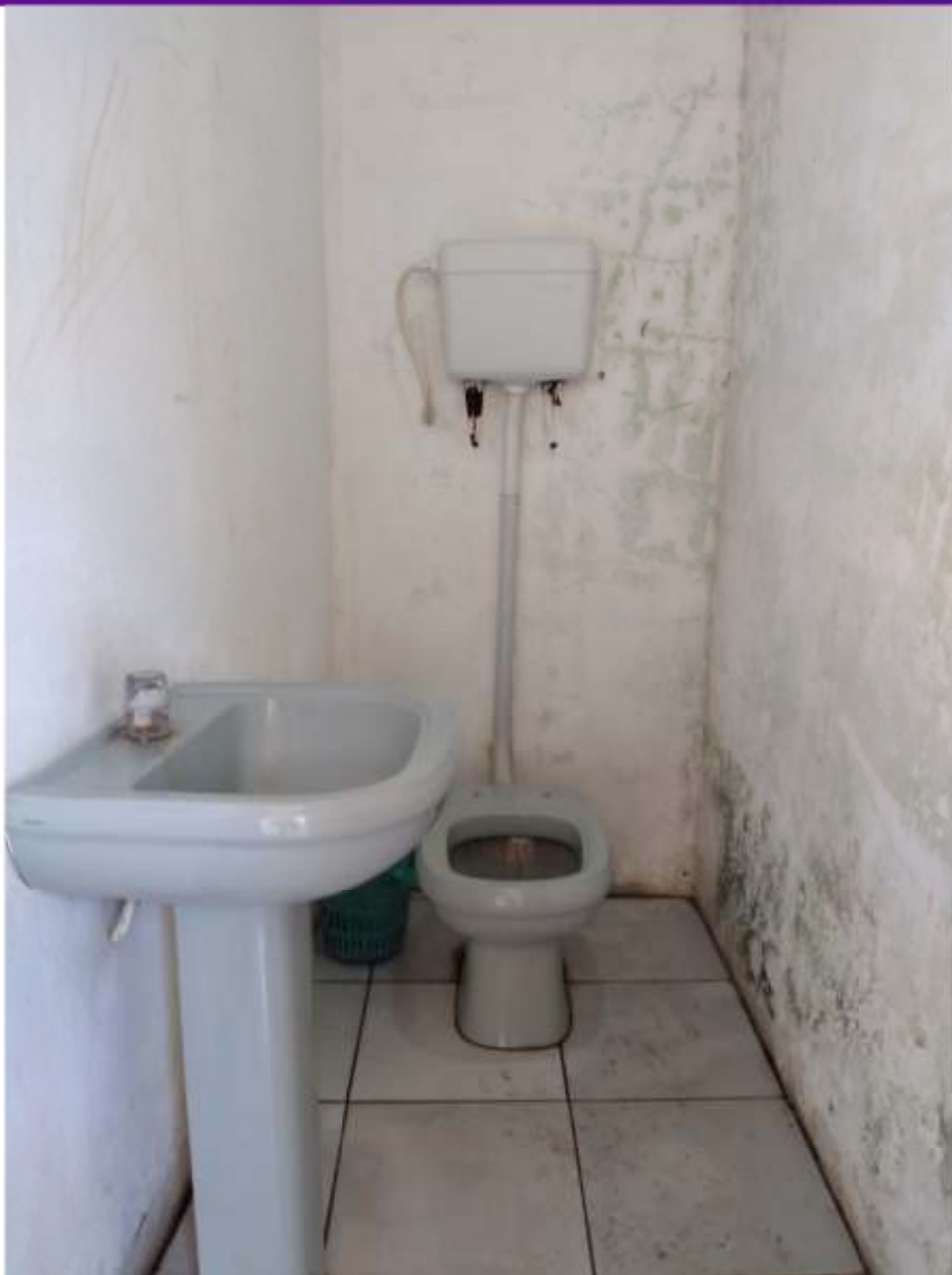
FOTO 09 – REVESTIMENTO CERAMICO NOS BANHEIROS COM REVISÃO DAS INSTALAÇÕES HIDROSANITÁRIAS
