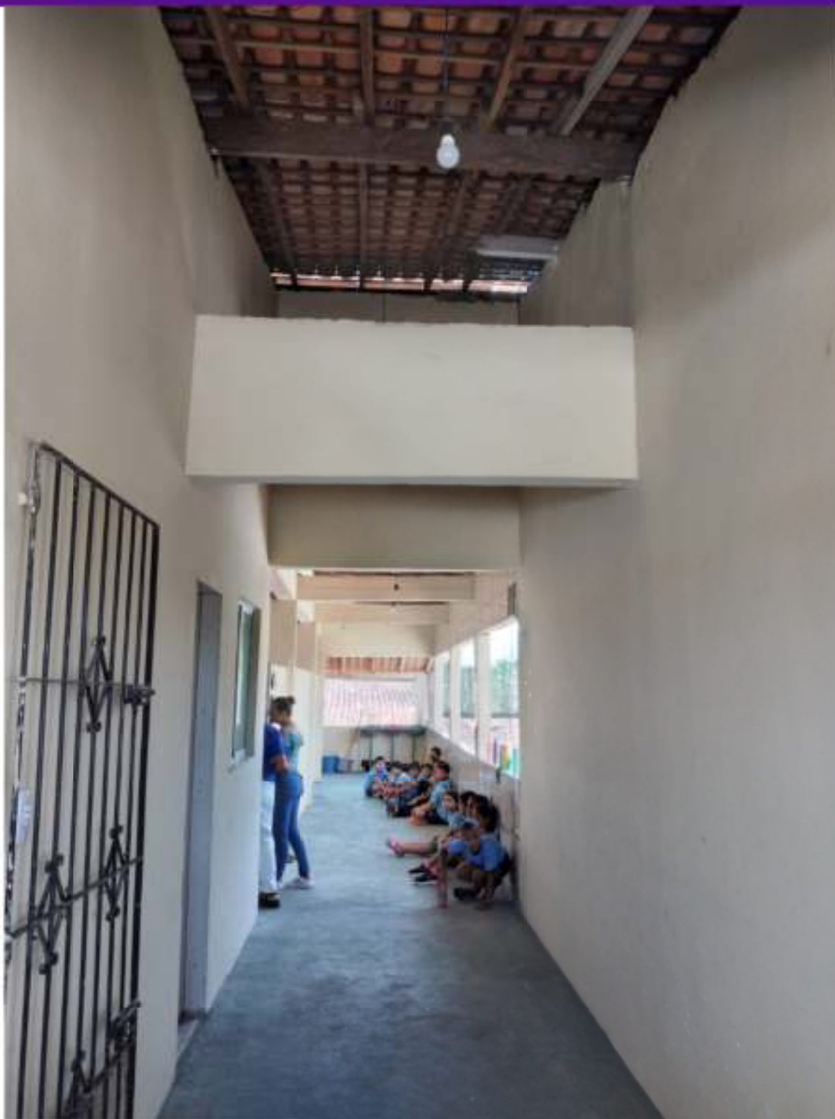
FOTO 12 – INSTALAÇÃO DE LAJOTA CERÂMICA NA CIRCULAÇÃO
