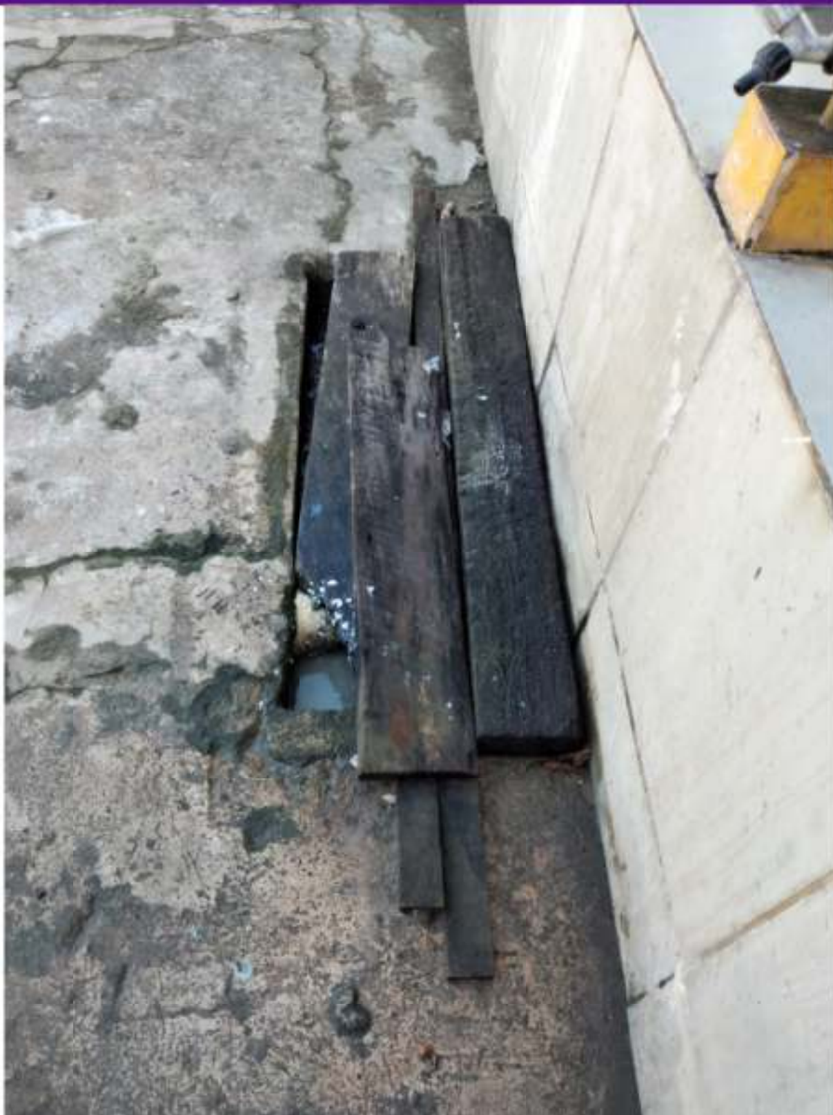
FOTO 06 – SUBSTITUIÇÃO DE TAMPA DE MADEIRA POR TAMPA DE CONCRETO NA CIAXA DE GORDURA E LIMPEZA NO SISTEMA DE ESGOTO
