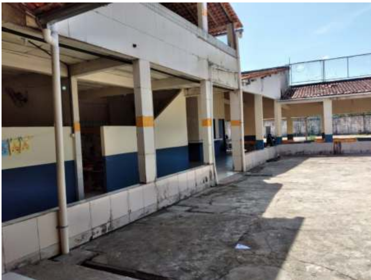
FOTO 03 – FECHAR AS PAREDES EM ALVENARIA NAS SALAS DE AULA E INSTALAÇÃO DE PORTAS E JANELAS PARA CLIMATIZAÇÃO
