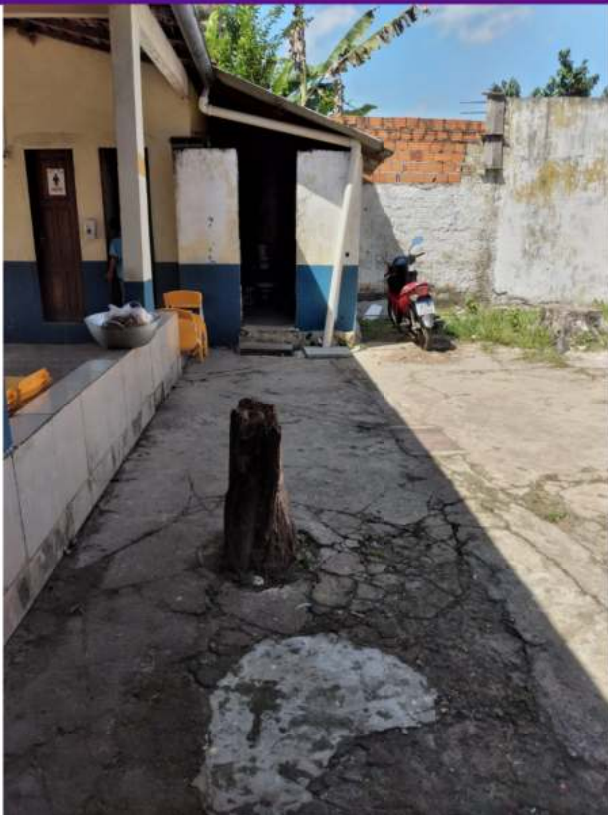
FOTO 05 – RECUPERAÇÃO DO PISO CIMENTADO COM RETIRADA DE TOCO DE ÁRVORE NA ÁREA LIVRE
