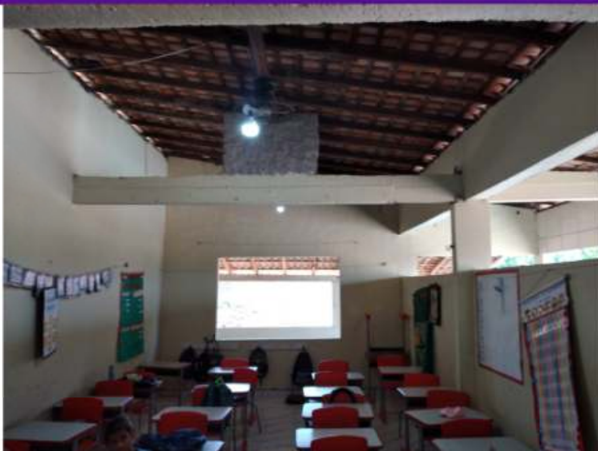
FOTO 11 – INSTALAÇÃO DE FORRO DE PVC E INSTALAÇÃO DE PORTAS E JANELAS NAS SALAS DE AULA
