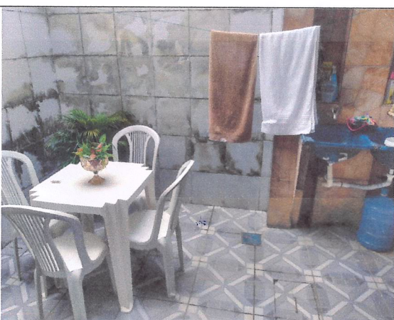
Foto 09: Área externa (pav. térreo).
