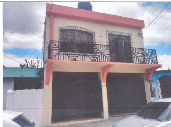
Foto 01: Fachada do imóvel.
