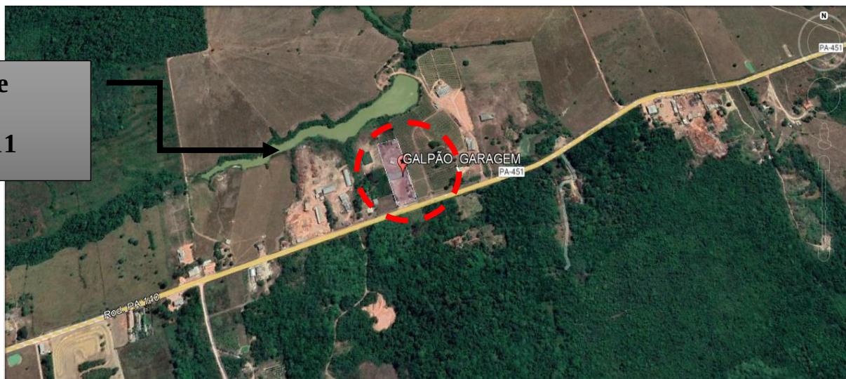
Localização Garagem para ônibus Escolar. Imagem: Google Earth
