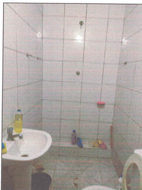
Foto 06: Alvenaria revestida (Baixo padrão). Fonte: Fonte: SEPLAN
