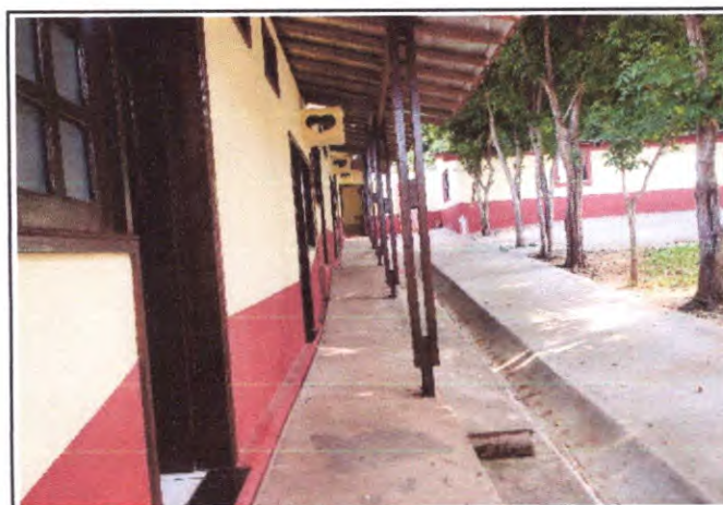
Foto 29: Piso grosso na área externa do imóvel.
