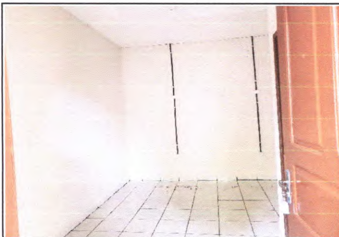
Foto 17: Forro em PVC e piso cerâmico.
