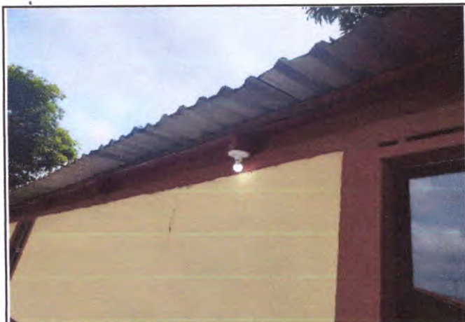
Foto 19: cobertura do bloco do refeitório em telhas galvanizadas com estrutura em madeira.
