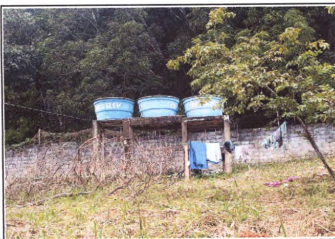
Foto 34: Caixas d'água localizadas na parte posterior do imóvel.
