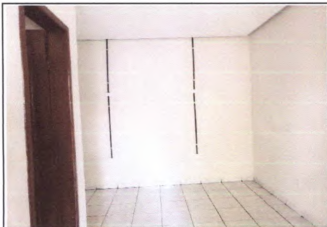
Foto 13: Piso cerâmico e forro em gesso.
