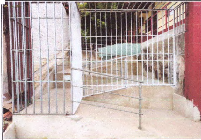
Foto 03: Portão de acesso secundário em ferro tipo grade.
