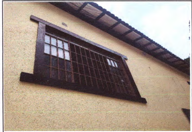
Foto 04: Janela em ferro com vidros e moldura em madeira.
