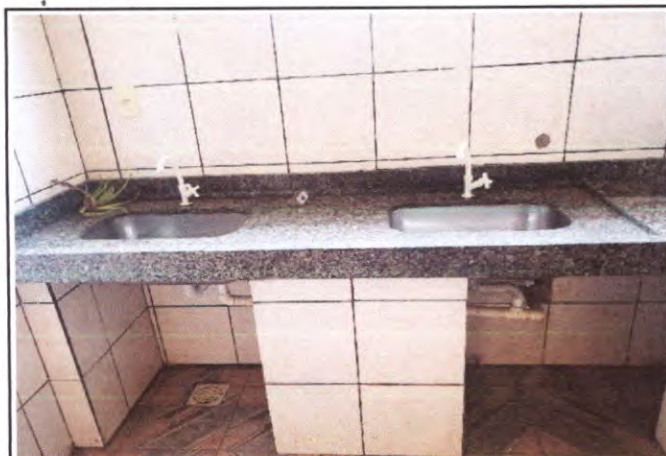
Foto 25: Cozinha com bancadas em granito, cubas em aço inox e torneiras em plástico.
