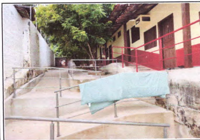
Foto 36: Rampa que dá acesso ao imóvel.
