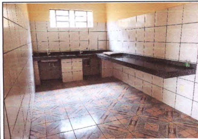
Foto 24: Cozinha com bancadas em granito e cubas em aço inox.
