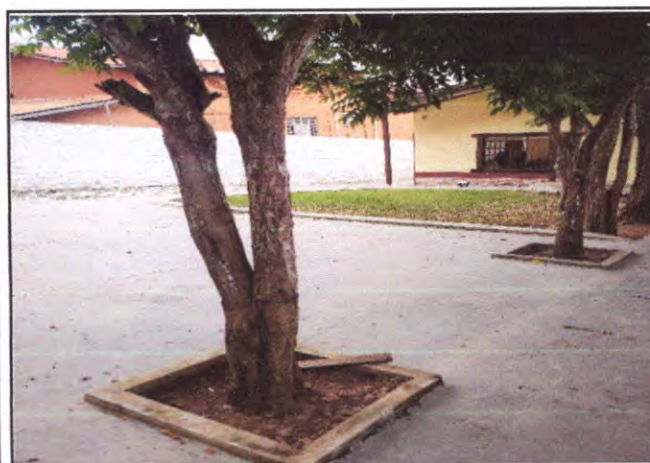
Foto 30: Piso grosso na área externa do imóvel.
