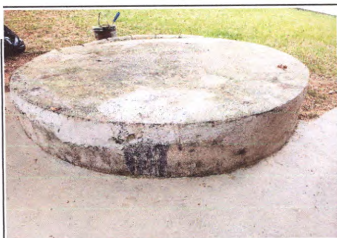
Foto 33: Poço no interior do imóvel.
