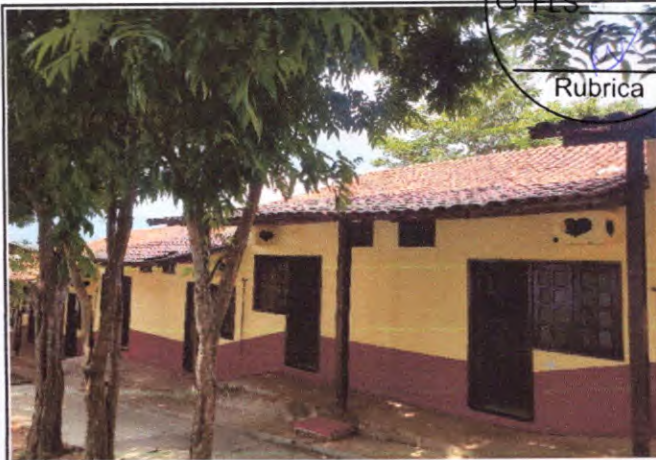
Foto 20: Cobertura em telhas de barro e estrutura em madeira.
