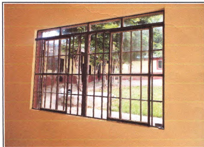
Foto 05: Janela em ferro com vidro.
