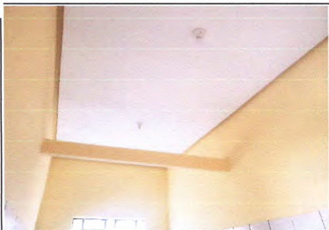
Foto 15: Forro em gesso.
