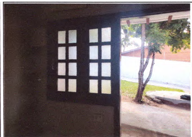
Foto 06: Janela em madeira com vidros.
