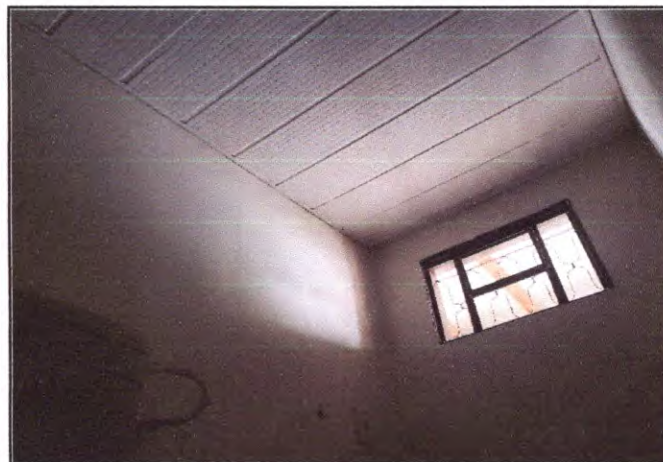
Foto 16: Forro em PVC.
