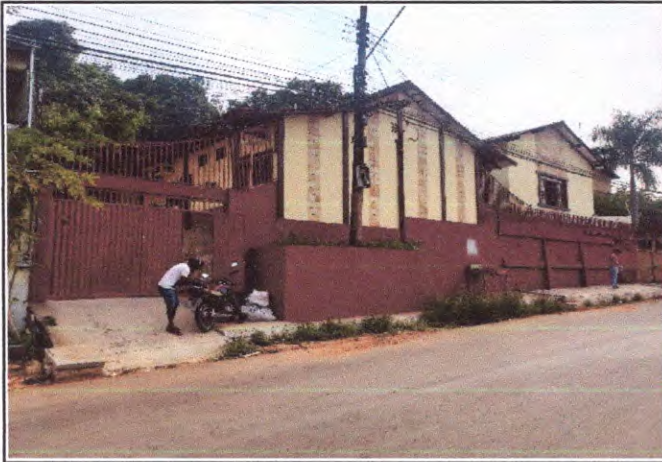
Foto 01: Fachada da edificação
