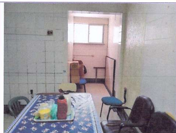
Foto 39: Refeitório (área da cozinha)
