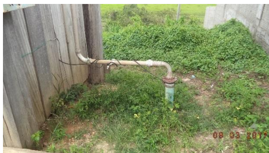
Vista PTP 4” – Prof. 100m – Barrilete 2” – 3,5CV – Vazão 7,5m³/h e Painel de Comando Elétrico
