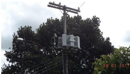
Rede de Alta 13.8 KV Transformador 112 KVA – PTP 6” Porf. 120m Barrilete 3” Vazão 15,0m³/h Bomba submersa 6 cv.
