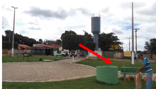
Praça Localização PTP 2 6" – Prof. 132m – Barrilete 2" – Bomba Submersa 7,5CV – Vazão 7,0m 3 /h
