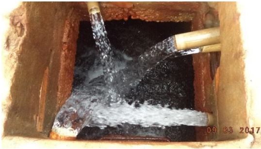
Chegada de Água dos PTP's ao Reservatório Apoiado RAP 227m³
