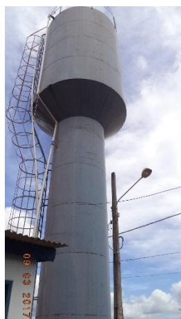
Painel de Comando PTP 1 / PTP 2 e Reservatório Elevado Metálico de Distribuição 60m 3
