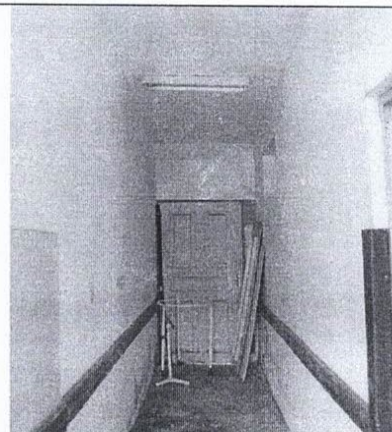
Foto2: Área de circulação do centro cirúrgico, piso sujo e manchado assim como a pintura da parede e das esquadrias, pontos elétricos precisando de revisão.
