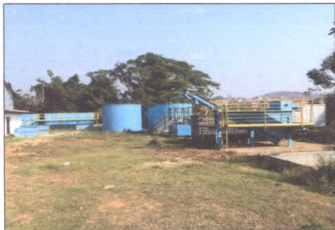
Foto 01 - Visão geral da ETE Vale do Sol
