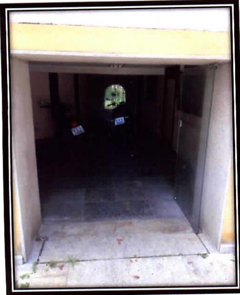
Porta de entrada do sub-solo em vidro temperado (necessita substituir folha e ferragens).
