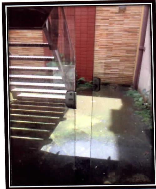
Revisão das esquadrias em vidro temperado, com substituição de ferragens danificadas.
