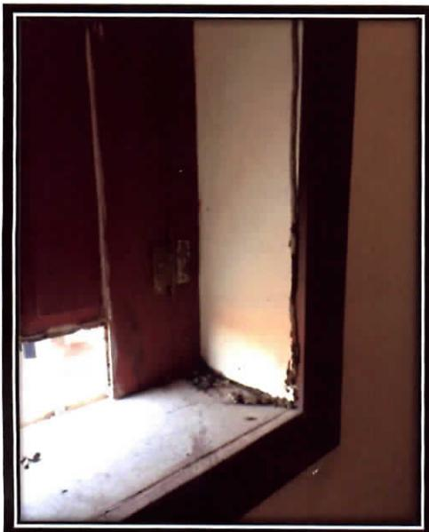
Substituição de esquadrias em madeira de lei e remoção de foco de cupim.
