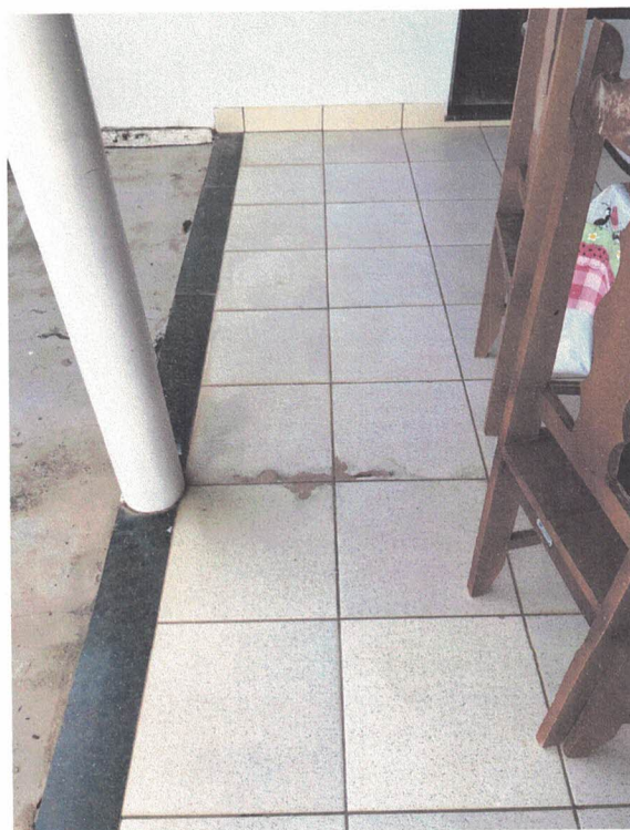
Imagem 59: piso da área de circulação coberta.
