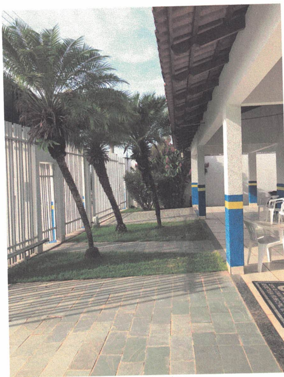
Imagem 08: jardim frontal e acessos da edificação.
