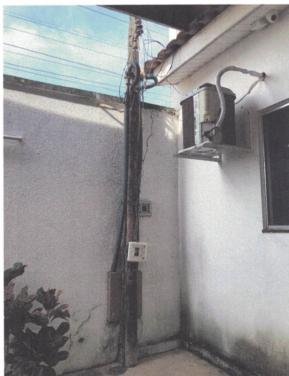
Imagens 53 e 54: poste localizado na área de convívio, com chave e fiações expostas.
