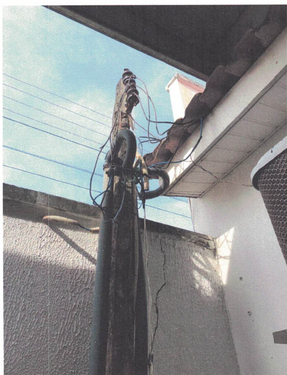
Imagens 53 e 54: poste localizado na área de convívio, com chave e fiações expostas.
