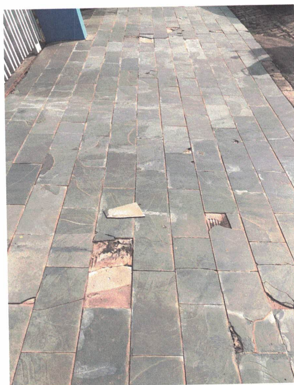
Imagem 07: calçada localizada na fachada principal.
