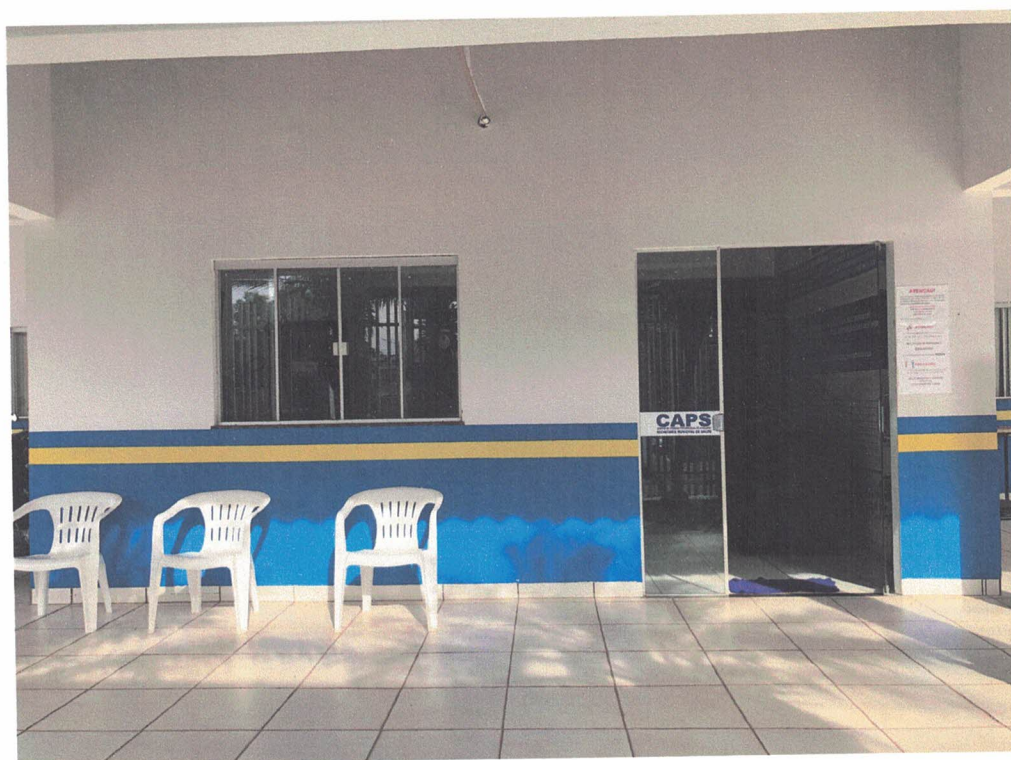
Imagem 18: vista da varanda frontal – porta de acesso principal à edificação.
