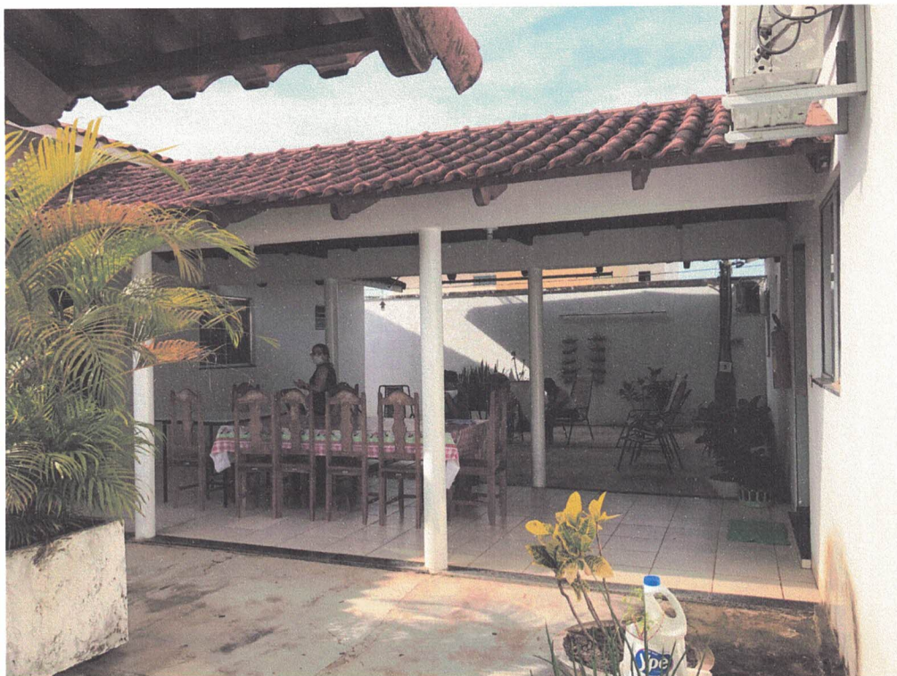
Imagem 60: vista área externa descoberta e área de circulação coberta/área de convívio.
