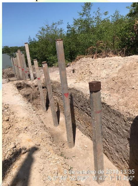
Figura 3: Estacas pré-moldadas do trecho reto de muro
