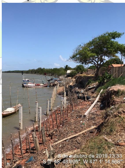
Figura 4: Estacas pré-moldadas do trecho inclinado do muro
