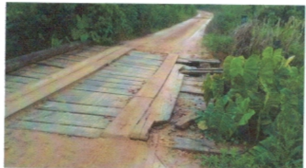
Ponte 6,00m – Vista do assoalho
