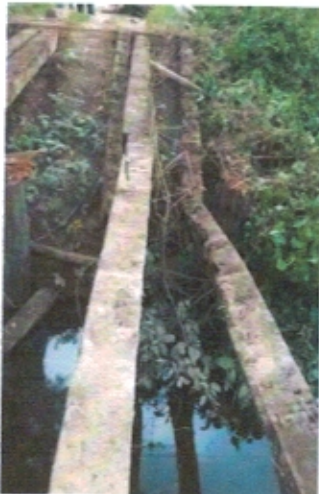
Ponte 15,00m – Vista das longarinas deterioradas
