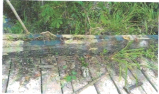
Ponte 10,00m – Vista da estaca sem a travessa já deteriorada Ponte 10,00m – Vista do assoalho com o guarda roda deteriorado
