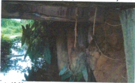
Ponte 10,00m – Vista da estaca sem a travessa já deteriorada Ponte 10,00m – Vista do assoalho com o guarda roda deteriorado
