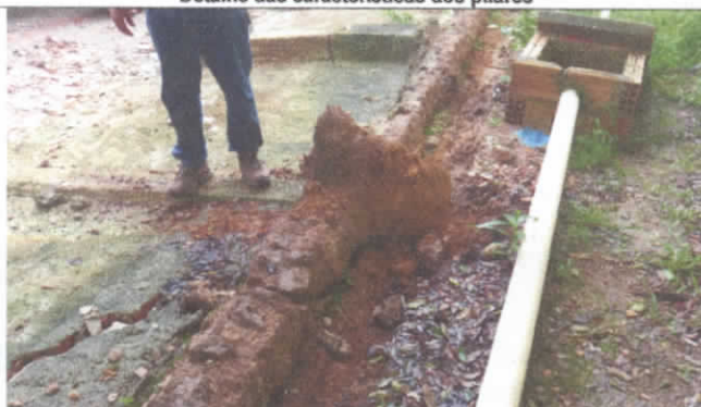
Vista do baldrame "raso" com pedra preta
