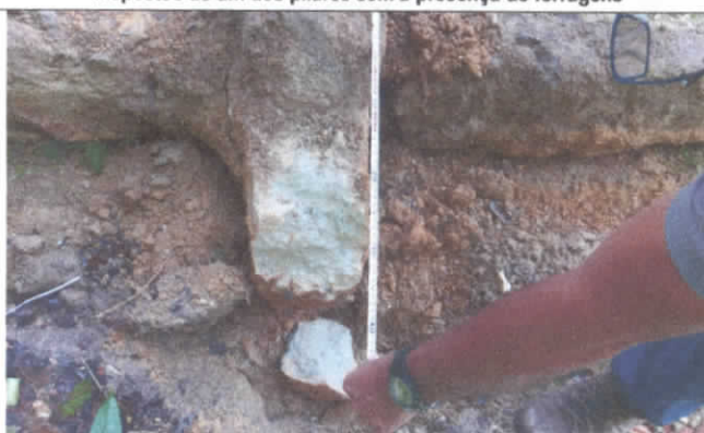
Detalhe das características dos pilares
