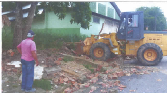
Início dos trabalhos de remoção de entulhos
