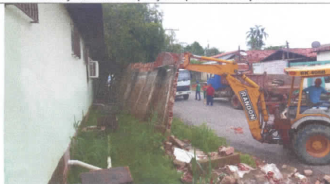
Retirada da panada que oferecia risco extremo
