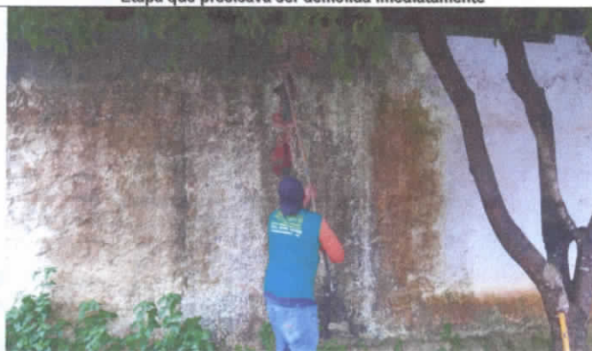
Serviço de corte de separação da parte mais comprometida
