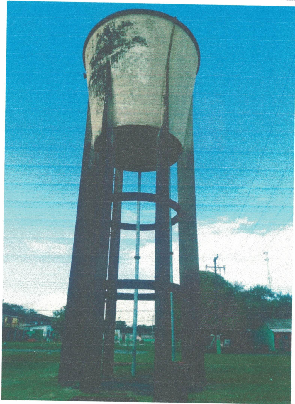
Figura: Elevado com capacidade do 40m 3 Obs: Não está em funcionamento
