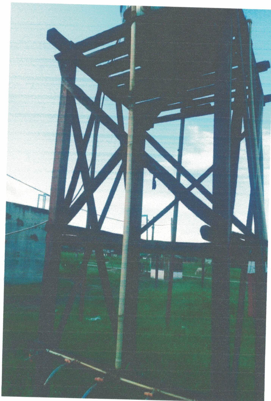
Figura 2: Elevado com capacidade de 3.000m/l a 5.000m/l
