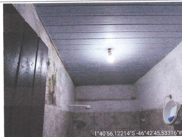
FOTO 05 – MANCHAS DE INFILTRAÇÃO
