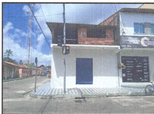
Foto 02: Vista principal do prédio.
