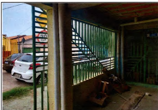
Foto 10: Portão de correr que dá acesso à garagem em ferro.
