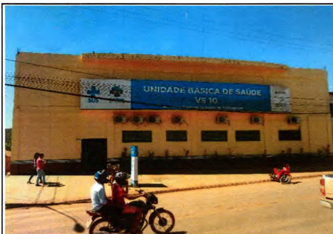
Foto 01: Fachada da edificação
