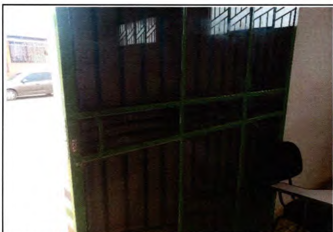
Foto 09: Portão da entrada principal em ferro com vidro.
