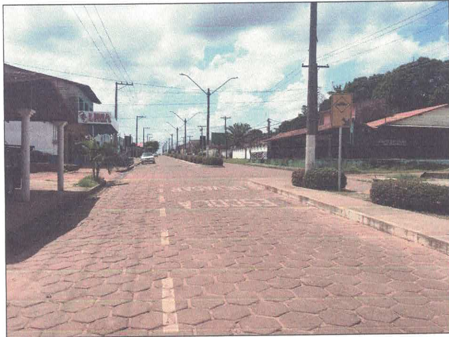
Vista longitudinal da Avenida Balbino Teixeira, sentido centro da cidade.
