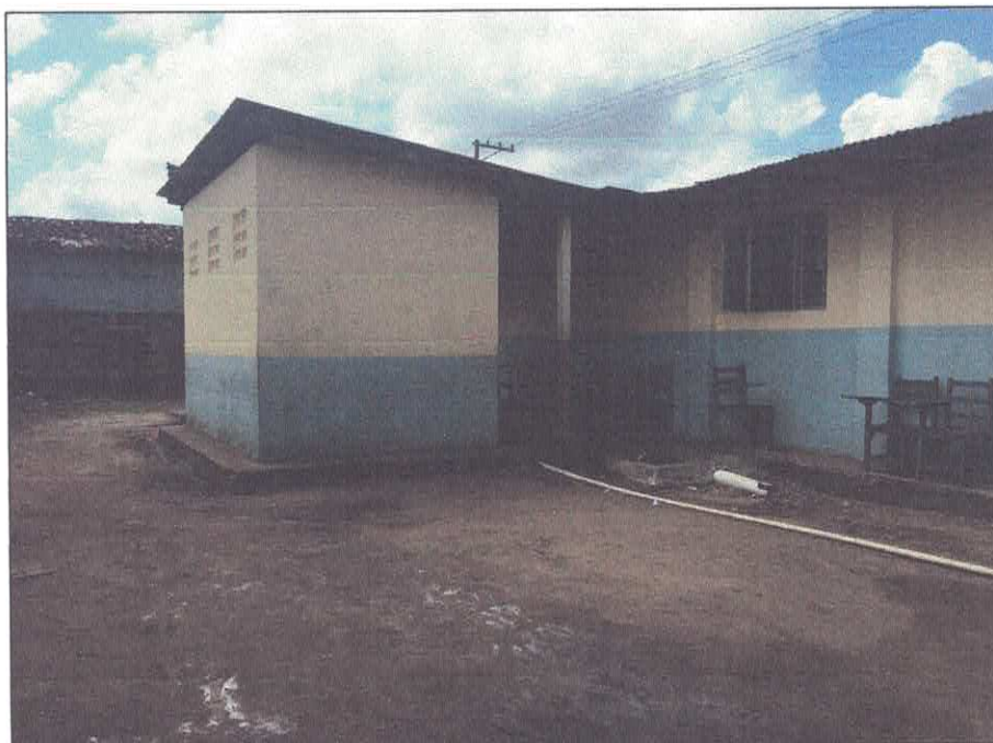
Vista longitudinal fachada posterior (fundos).
