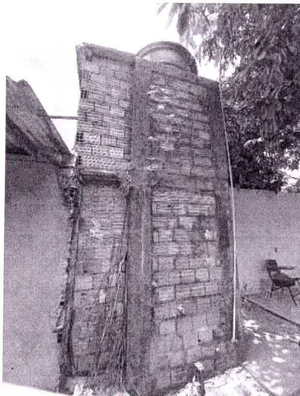
Figura 36 – Estrutura da caixa d'água
