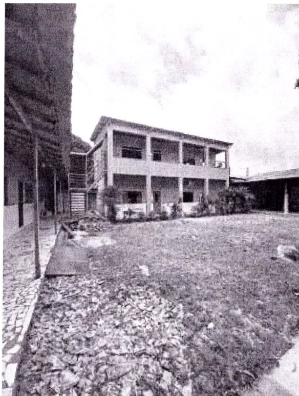
Figura 31 – Edificação 2 pavimentos e área livre.
