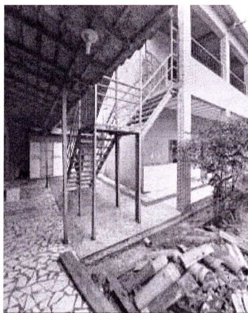
Figura 10 – Escada metálica de acesso ao 1º pavimento.
