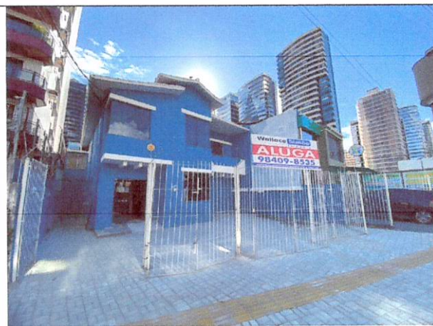
Foto 02: Entrada do imóvel.
