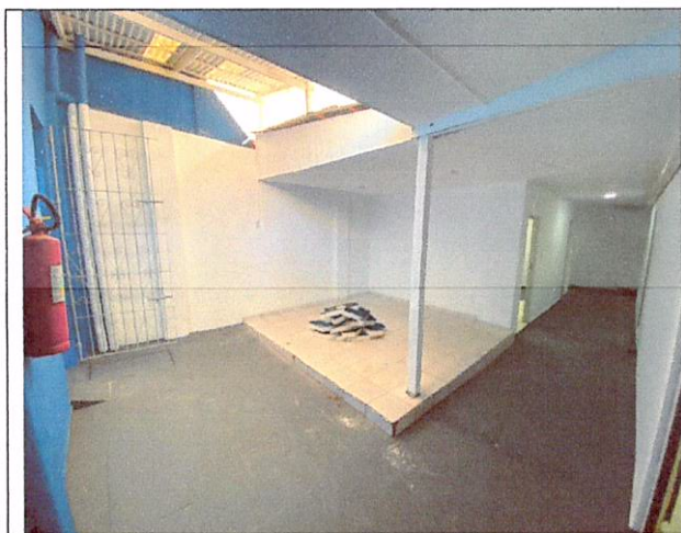
Foto 11: Área de ventilação.
