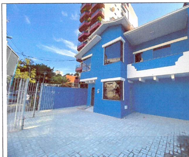
Foto 03: Estacionamento do imóvel.
