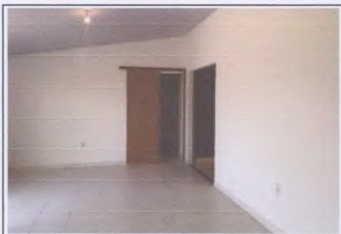
Foto 06: Hall de entrada.
