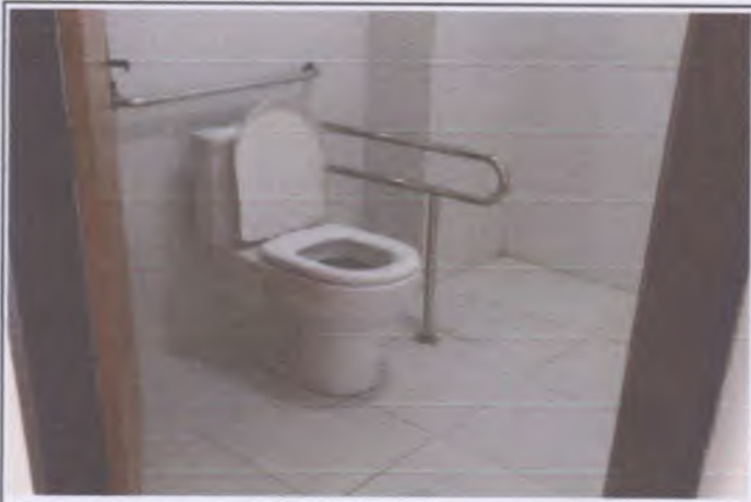
Foto 13: Sanitário do banheiro PCD atendendo as normas de acessibilidade.
