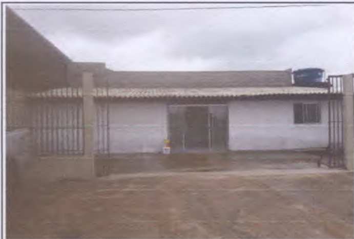
Foto 01: Fachada da edificação.
