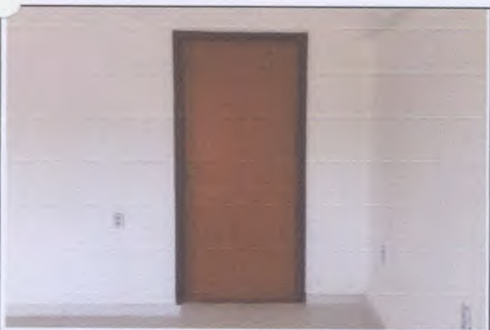
Foto 35: Porta de entrada da sala 06.
