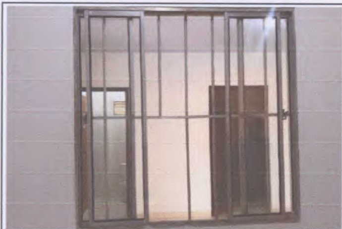
Foto 31: Detalhes da esquadria localizada na sala 04.
