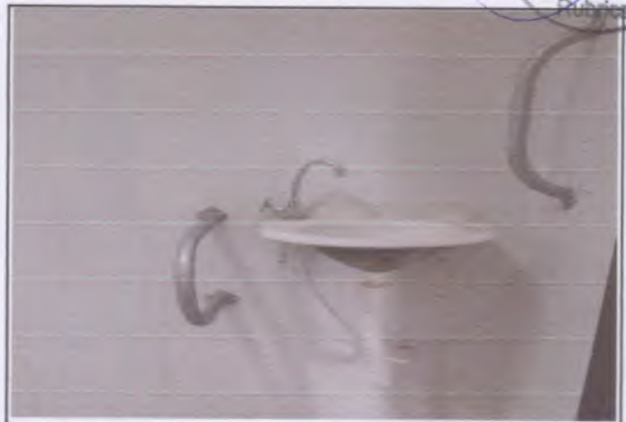
Foto 14: Lavatório do banheiro PCD atendendo as normas de acessibilidade.
