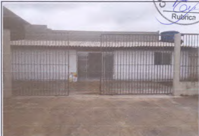
Foto 02: Fachada da edificação.
