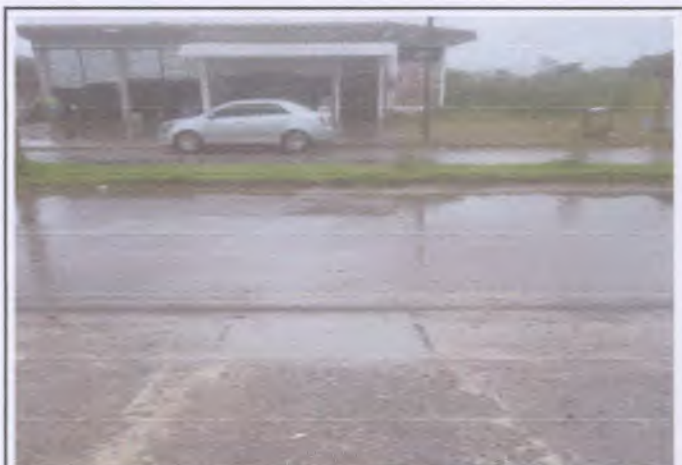
Foto 04: Rampa localizada na entrada principal atendendo as normas de acessibilidade.
