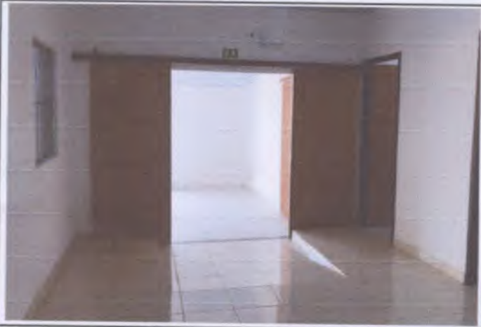
Foto 09: Entrada da recepção.
