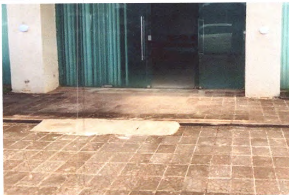
Foto 02: Rampa localizada na entrada do imóvel atendendo às normas de acessibilidade.
