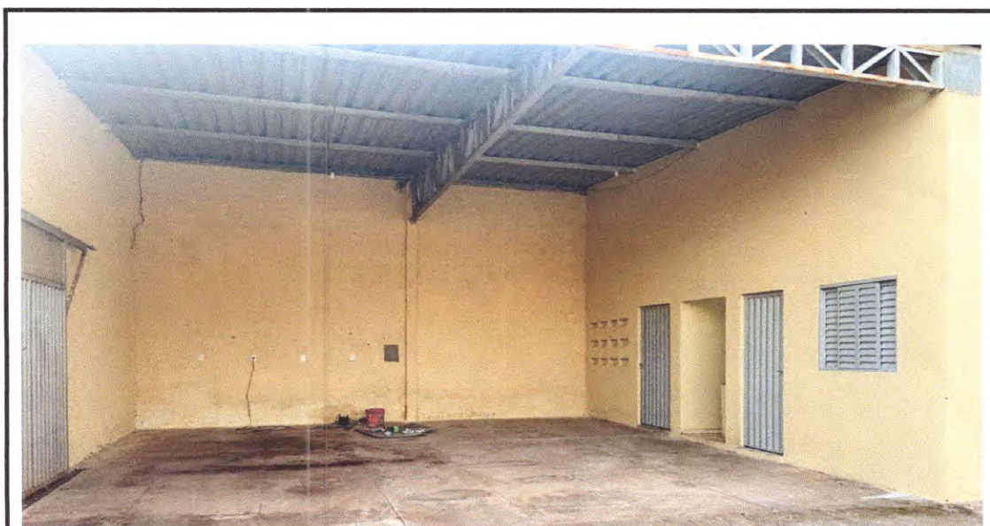
Foto 14: Terraço do Prédio Anexo.
