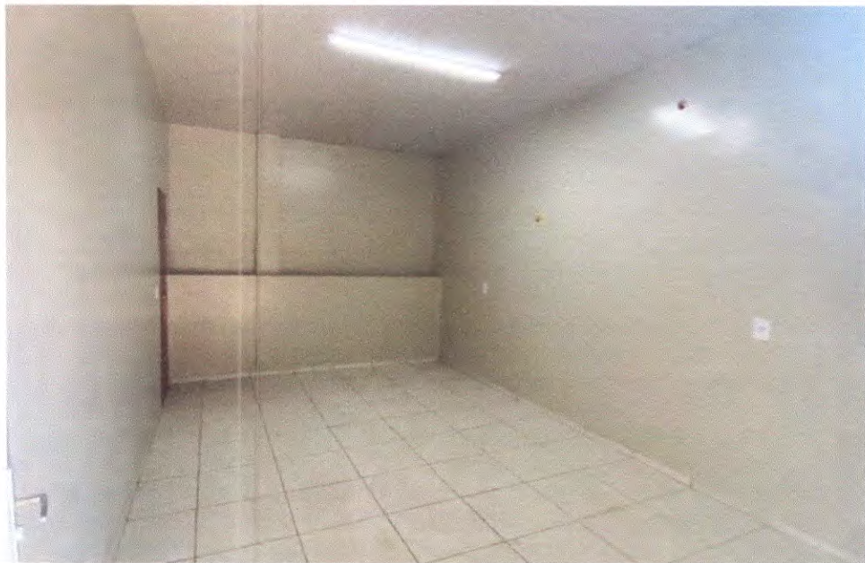
Foto 10: Quarto 01 do Prédio Anexo.
